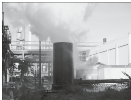
การติดตั้งอุปกรณ์ลดเสียงภายในโครงการก่อสร้าง
