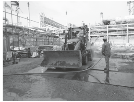
ภาพการฉีดพรมน้ำลงบนถนนภายในและบริเวณโดยรอบโครงการ และการทำความสะอาดล้อรถยนต์ก่อนออกจากพื้นที่โครงการ
